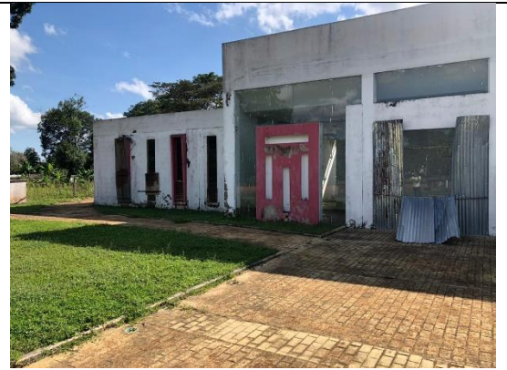
Foto No. 30 Puerto Lleras 5/11/2020
