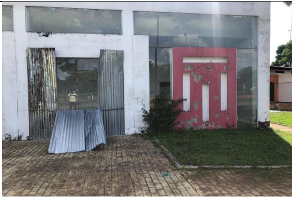
Foto No. 29 Puerto Lleras 5/11/2020.
