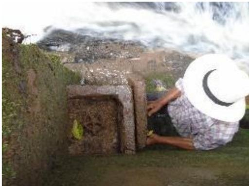
**Fotografía 5.** Registro de lavado Desarenador
