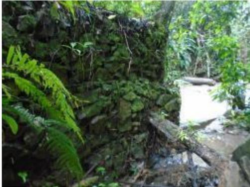
**Fotografía 9.** Gavión de sostenimiento del Desarenador
