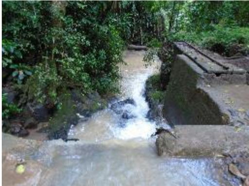
**Fotografía 3.** Vista Superior Bocatoma y Desarenador
