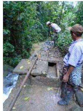
**Fotografía 6.** Vista Frontal del Desarenador
