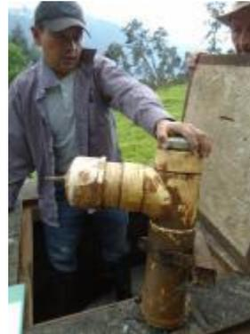
**Fotografía 104.** cámara de quiebre N°2 sistema de flotador
