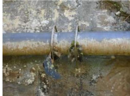
**Fotografía 28.** Paso elevado N°3 (anclajes a la roca)
