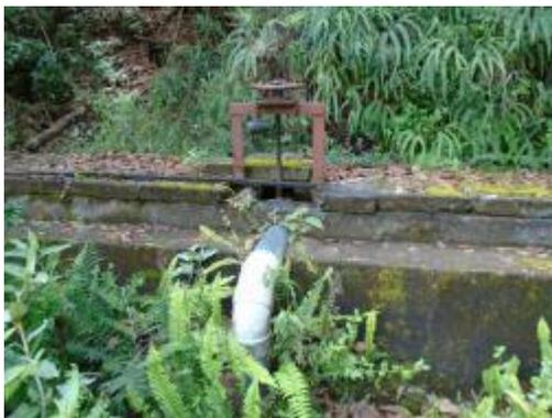
**Fotografía 14.** Rebose y Compuerta para lavado Desarenador
