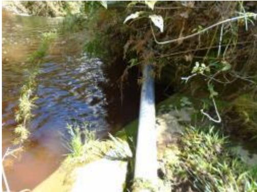
**Fotografía 8.** Tubería de aducción en voladizo
