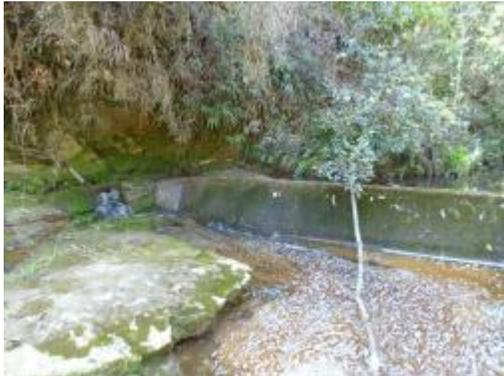
**Fotografía 3.** Vista Frontal del dique con infiltraciones
