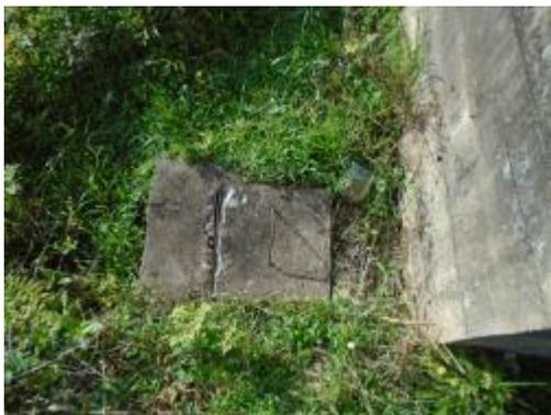
**Fotografía 105.** cámara de quiebre N°2 sistema de lavado
