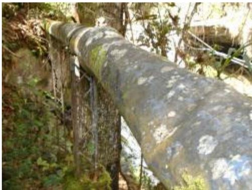
**Fotografía 10.** Tubería deteriorada
