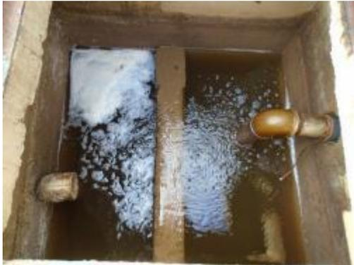
**Fotografía 103.** cámara de quiebre N°1 cámara Húmeda
