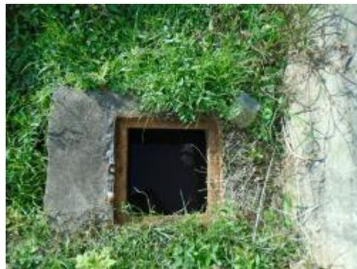
**Fotografía 106.** cámara de quiebre N°2 sistema de lavado
