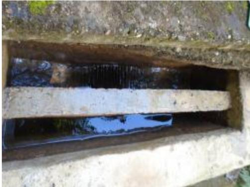
**Fotografía 18.** Cámara de Salida Desarenador
