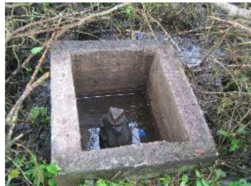
**Fotografía 4.** Válvula de Lavado de la Represa.
