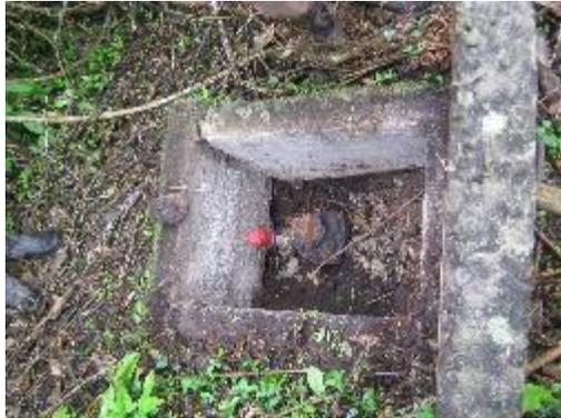
**Fotografía 9.** Válvula de aire y Válvula de Corte
