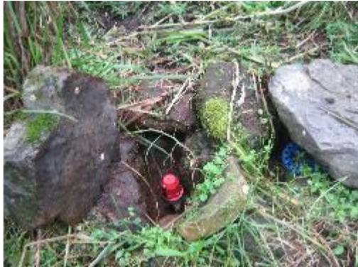
**Fotografía 11.** Válvula de aire y Válvula de Corte
