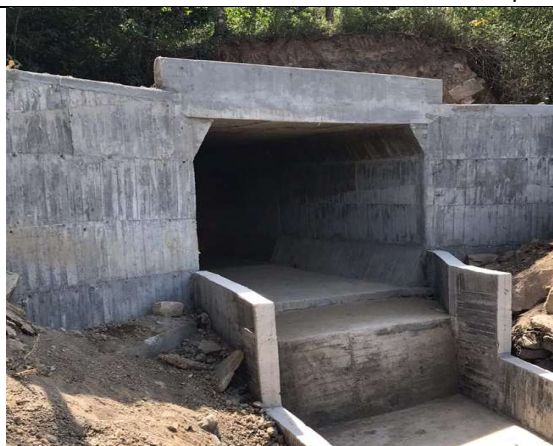
6 construcción Box Colbert Municipio de Chaguani - Vereda Honduras
