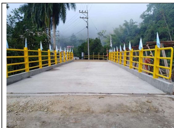
1 Puente Vehicular Municipio Palma - Inspección Murca
