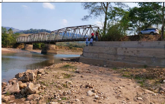
8 rehabilitación estribo derecho puente vehicular municipio de Medina
