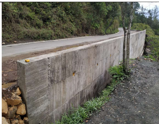
4 construcción Muro de contención vía Gachetá - Ubalá sector Chusmeque
