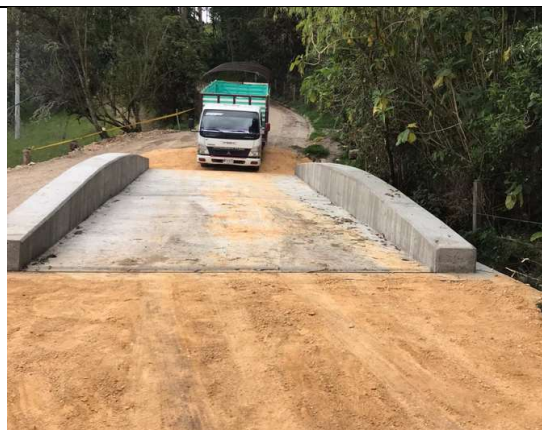
3 construcción Puente Vehicular Municipio de El Rosal - Sector Canelones
