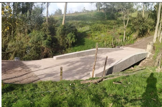
7 construcción Puente Vehicular Municipio de Une - Sector Raspados
