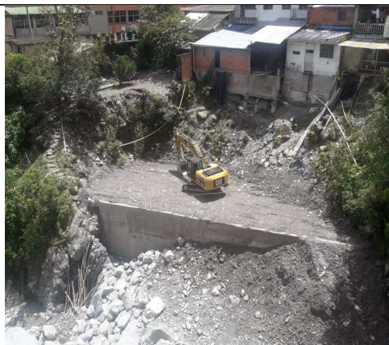
12 construcción muro de Contención - Municipio Guayabetal
