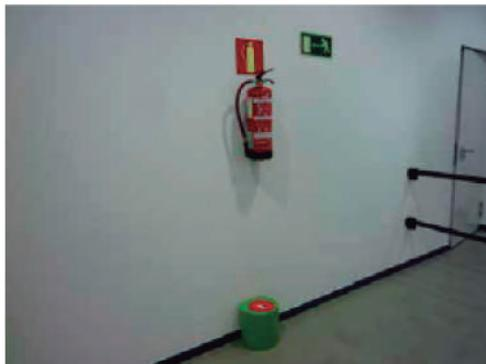
*En esta imagen podemos ver como se ha marcado la proyección en el suelo mediante un elemento señalizador del extintor que constituye un elemento volado por debajo de 220 cm. De esta forma el elemento puede ser localizado evitando colisiones.*
