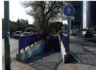
Ejemplo de paso subterráneo en el que podemos ver la señalización vertical del mismo en azul y blanco, la señalización horizontal mediante un pavimento táctil de botones y color diferenciado y pasamanos laterales para ayudar al desplazamiento por la ruta en pendiente.
