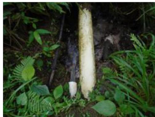
**Fotografía 18.** Tubería de Excesos y Lavado
