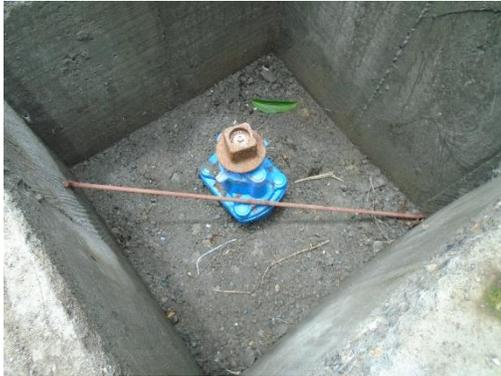
**Fotografía 23.** . Vista Válvula de Corte
