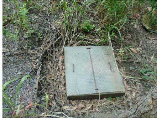
**Fotografía 19.** Vista Superior caja Válvula de Aire
