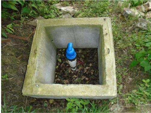
**Fotografía 18.** Vista Interna Válvula de Aire
