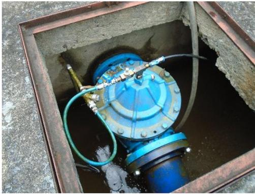
**Fotografía 28.** Válvula de control de nivel
