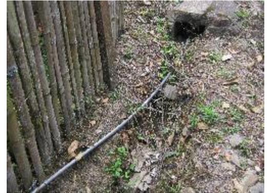
Fotografía 8. Tubería de Conducción a Nivel Suelo
