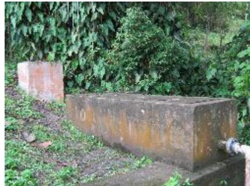
**Fotografía 6.** Vista Frontal del Desarenador
