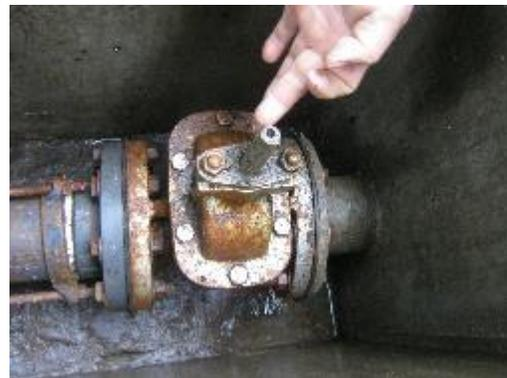
**Fotografía 8.** Válvula de lavado del Desarenador
