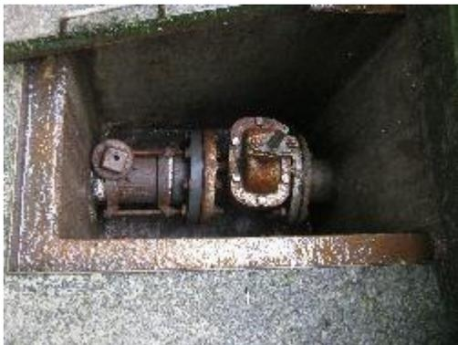
**Fotografía 7.** Válvula de lavado del Desarenador
