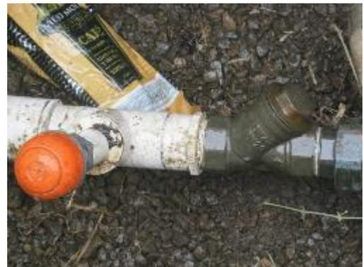
**Fotografía 20.** Válvula de Reguladora de Presión # 2
