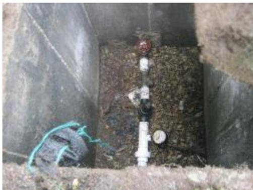
**Fotografía 19.** Válvula de Reguladora de Presión # 1
