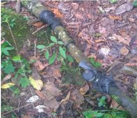
**Fotografía 14.** Vista Lateral Válvula de Aire
