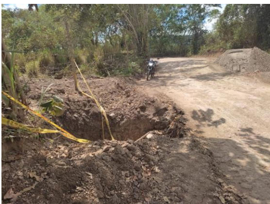
Fotografía 10. Excavación del encole de una de la alcantarilla que se han construido en la vía terciaria
