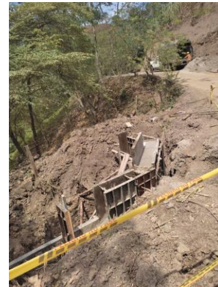
Fotografía 9. Etapa de construcción del descole de una alcantarilla en la vía terciaria
