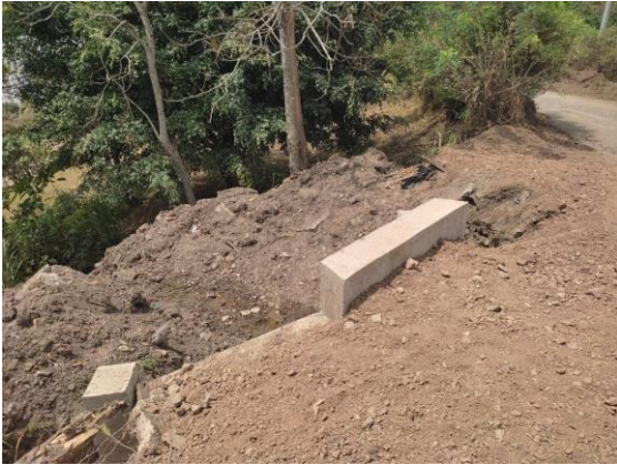
Fotografía 6. Descole de alcantarilla construida en la vía terciaria que garantiza la transitabilidad de la comunidad
