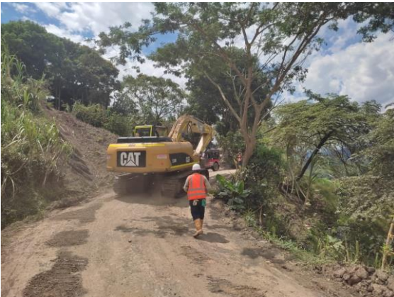
Fotografía 8. Adecuación de la vía terciaria para garantizar la transitabilidad en el corredor
