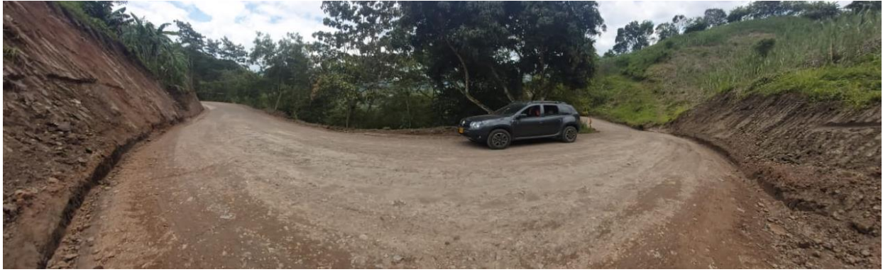
Fotografía 1. Ampliación de los radios de giro de las vía conocida como alterna
