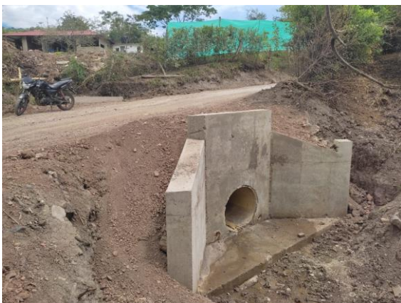
Fotografía 12. Descole construido en las alcantarillas terminadas
