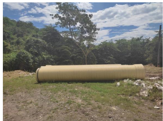
Fotografía 11. Tubería utilizada en la construcción de las alcantarillas
