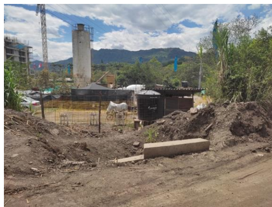
Fotografía 13. Estado del descole construido en una de las alcantarillas terminadas
