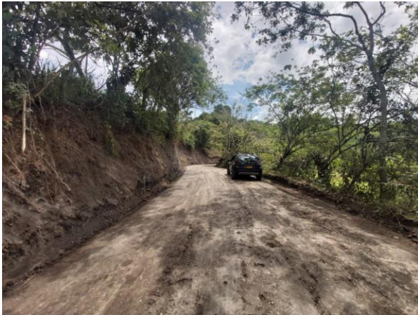
Fotografía 1. Ampliación de los radios de giro de las vía conocida como alterna
