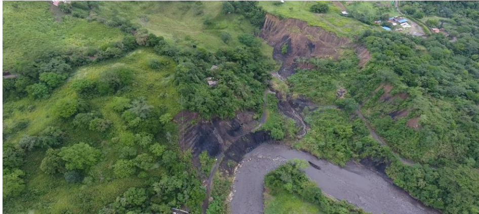
Figura 1. Estado del Sector del Peñón donde se encontraba el puente que fue desmontado ante las condiciones de inestabilidad del terreno por la geología regional
