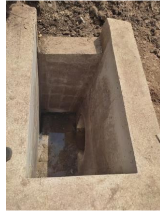
Fotografía 7. Encole de alcantarilla construida en la vía terciaria
