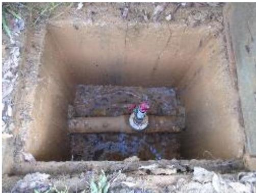
**Fotografía 23.** Vista Superior caja Válvula de Aire
