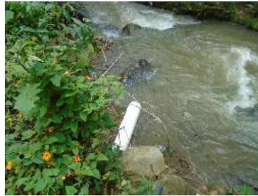
Fotografía 8. Desagüe del desarenador
