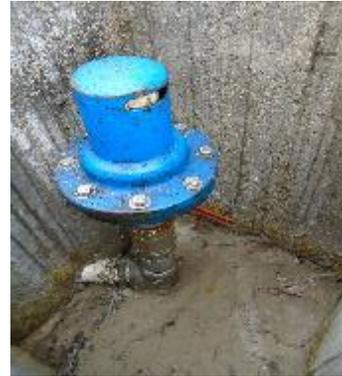
**Fotografía 29.** Válvula ventosa 2 (Después de la estación de filtrado)
