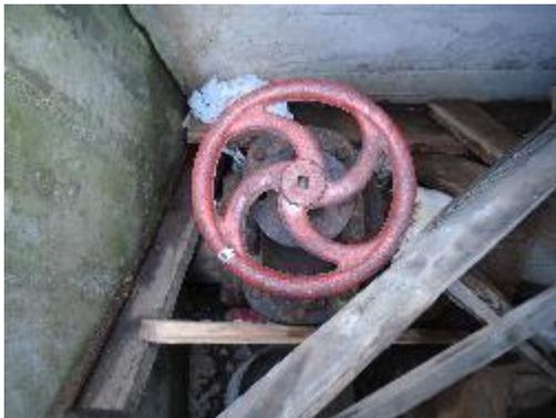
**Fotografía 24.** Válvula de corte a la salida del desarenador
