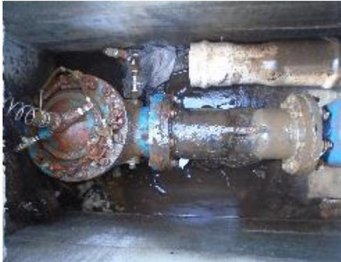
**Fotografía 53.** Válvula reguladora de nivel y filtro, Cámara de quiebre 4
