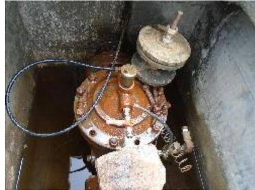
**Fotografía 35.** Válvula reguladora de nivel, Cámara de quiebre 1
