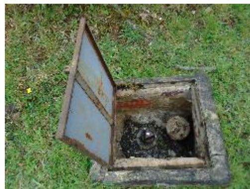
**Fotografía 33.** Válvula de corte 8 y Válvula ventosa 4
