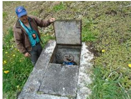
**Fotografía 37.** Caja de válvulas, Cámara de quiebre 1
