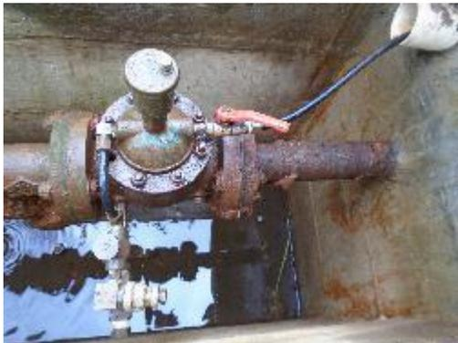
**Fotografía 47.** Válvula reguladora de nivel, Cámara de quiebre 3
