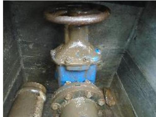
**Fotografía 54.** Válvula de corte, Cámara de quiebre 4
