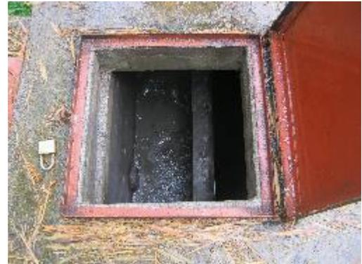
**Fotografía 12.** Zona de Salida del Desarenador
