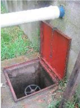
**Fotografía 11.** Cámara del Registro de Lavado y Desagüe del vertedero de Excesos
