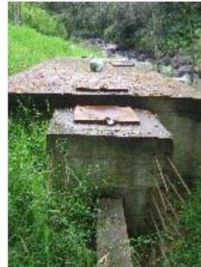
**Fotografía 10.** Vista Frontal del desarenador
