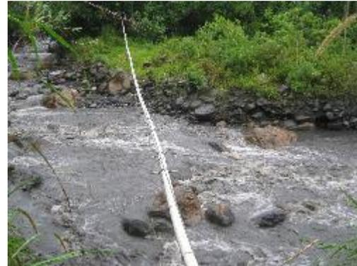
**Fotografía 32.** Viaducto de 3” en tubería de PVC
