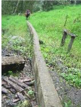
**Fotografía 7.** Tramo de tubería encofrado
