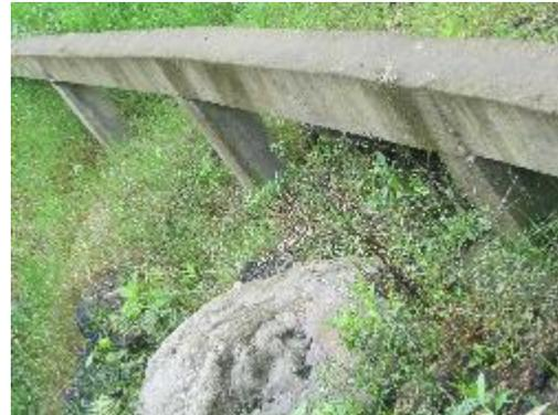
**Fotografía 8.** Tramo de tubería encofrado
