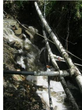
**Fotografía 30.** Viaducto de 4” en tubería de PVC
