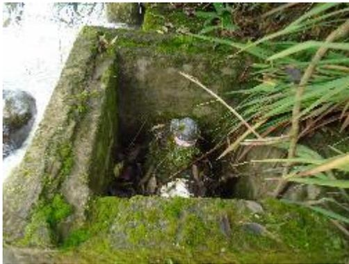
**Fotografía 31.** Válvula ventosa 1 (en la bocATOMA)
