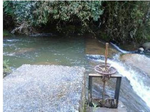
**Fotografía 4. Bocatoma - Compuerta**
