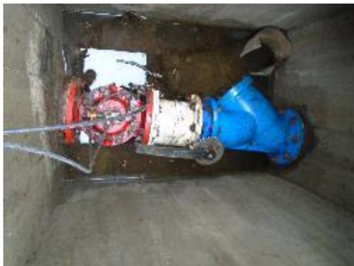
**Fotografía 41.** Caja de válvulas, Cámara de quiebre 1
