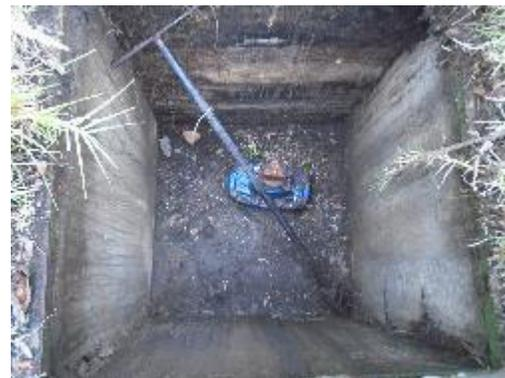
**Fotografía 44.** Válvula de corte, Cámara de quiebre 1
