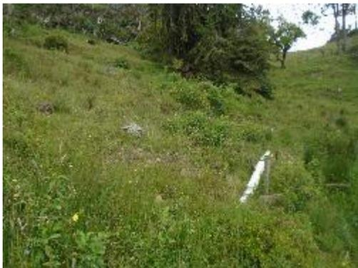
**Fotografía 29.** Instalación superficial por falla geológica
