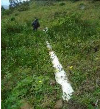
**Fotografía 25.** Instalación superficial por falla geológica
