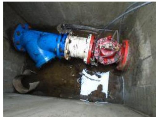
**Fotografía 42.** Caja de válvulas, Cámara de quiebre 1
