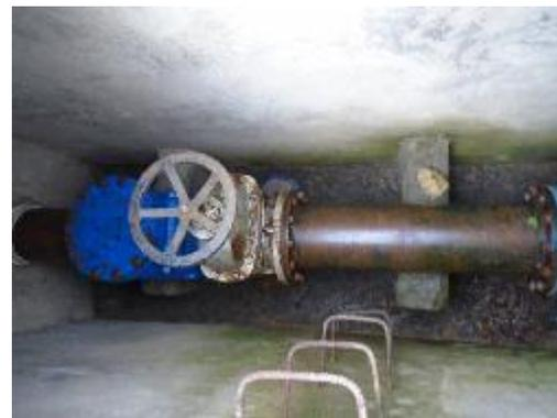
**Fotografía 14.** Macromedidor- Válvula de corde
