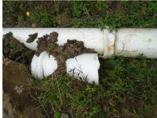
**Fotografía 26.** Instalación superficial por falla geológica
