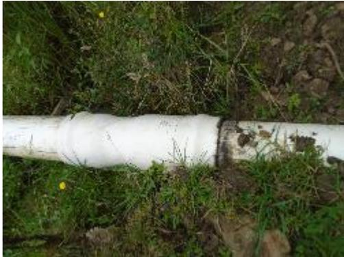
**Fotografía 27.** Instalación superficial por falla geológica
