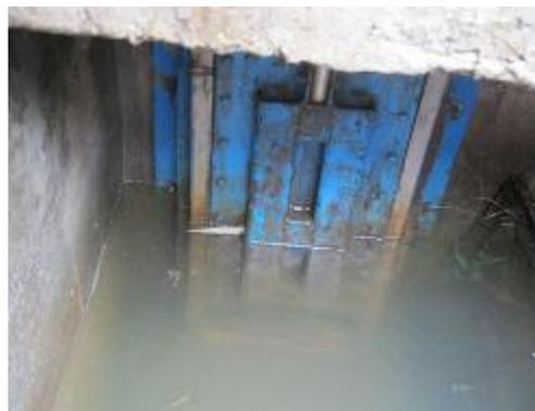
Fotografía 4. Compuerta de Guillotina
