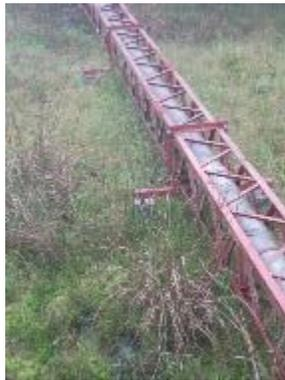
Fotografía 27. Viaducto No 1 de 6" en tubería de PVC
