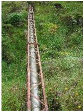
Fotografía 29. Viaducto No 3 de 6" en tubería de PVC
