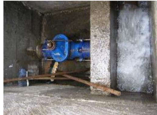
Fotografía 10. Registro de Lavado y Desagüe del Vertedero Excesos
