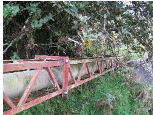
Fotografía 30. Viaducto No 4 de 6" en tubería de PVC
