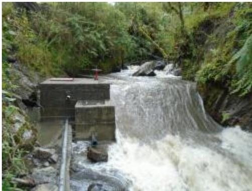
Fotografía 6. Aducción en tubería Metálica
