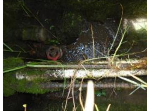
**Fotografía 15.** Válvula de salida y tapón para lavado.
