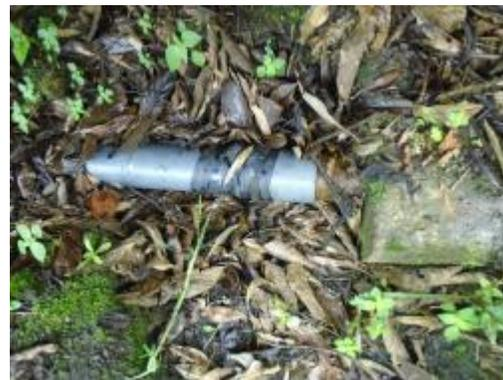
Fotografía 9. Transición tubería Metálica - PVC
