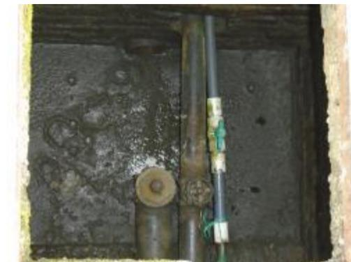
**Fotografía 46.** . Válvula de salida y lavado
